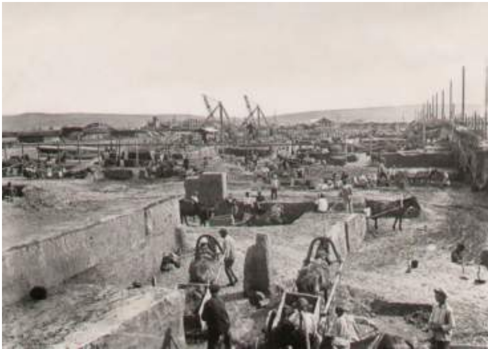
Строительство Кузнецкого металлургического комбината. Начало 1930х гг.
